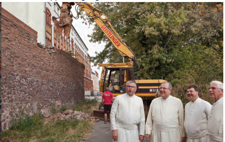
Abbrucharbeiten zur Elbseite
