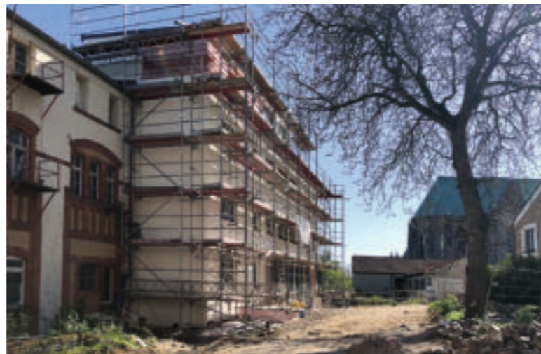
Fast fertige Fassade zur Hofseite im Mai 2023
